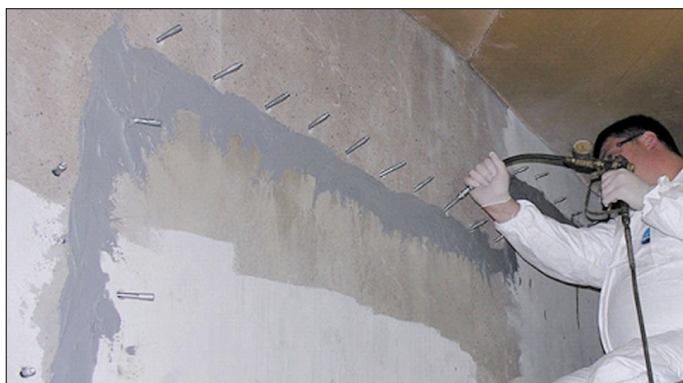
Fot. 2. Tłoczenie środka WEBAC 1660 poprzez zamocowane iniektory w obszarze spękania
